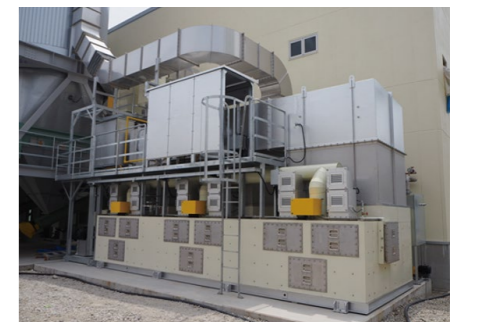
導入予定の省エネルギー設備(蓄熱式脱臭装置)： ナイツック工業(日本)
