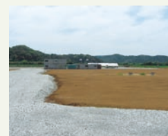
造成工事の様子
